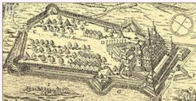
Utvrda Novi Zrinj
